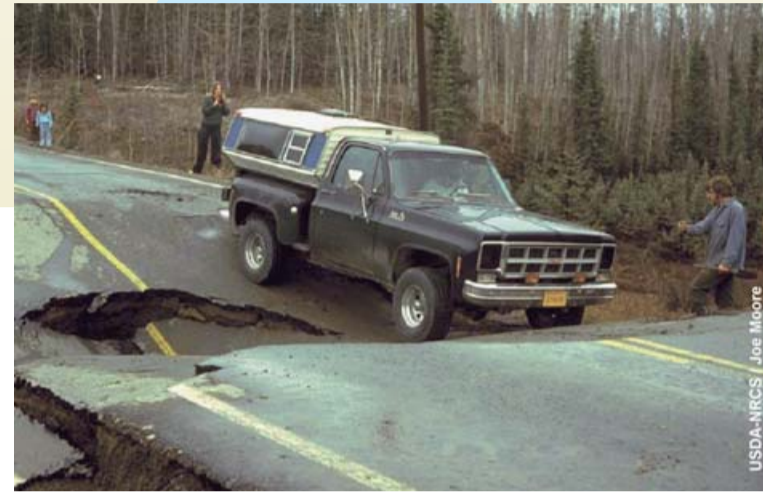
Effondrement d'une route en Alaska
