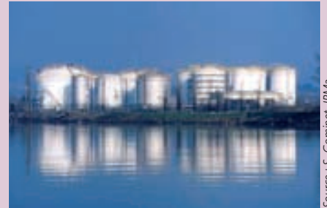
Salaise-sur-Sanne, Rubis Stockage (Isère). Stockage de produits chimiques et pétroliers.
