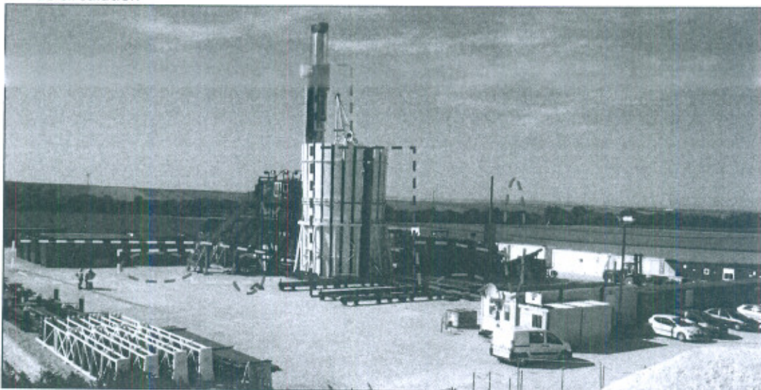
Emprise d'un forage pétrolier
