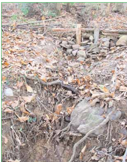
Barrage en rondins
