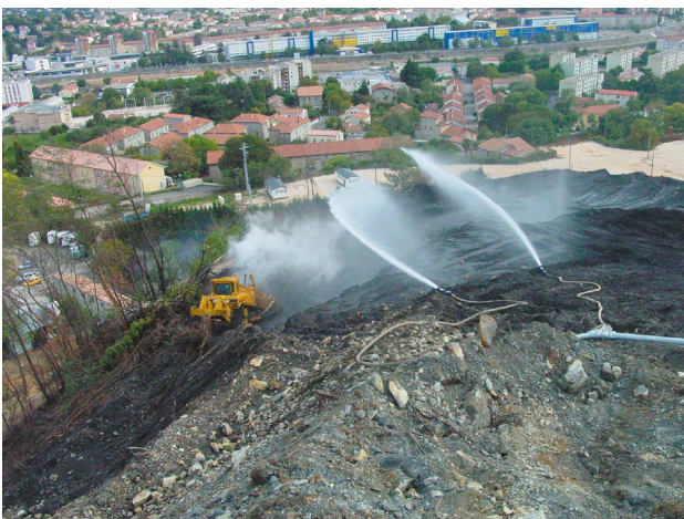
Photographie 6 : défournement et arrosage d'un terril en combustion, bassin minier du Gard
