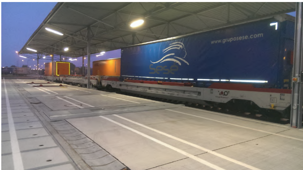
instalaciones de terminal a partir de 25m de ancho (sin estacionamiento. Imagen: Instalación manipuladora de 17m de ancho)
