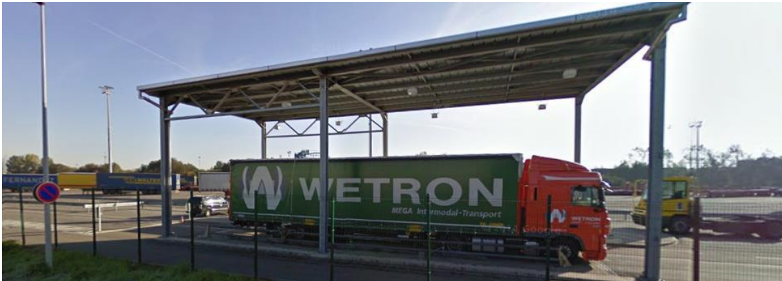
Figura 2-14. Báscula con control de gálibo y peso.
