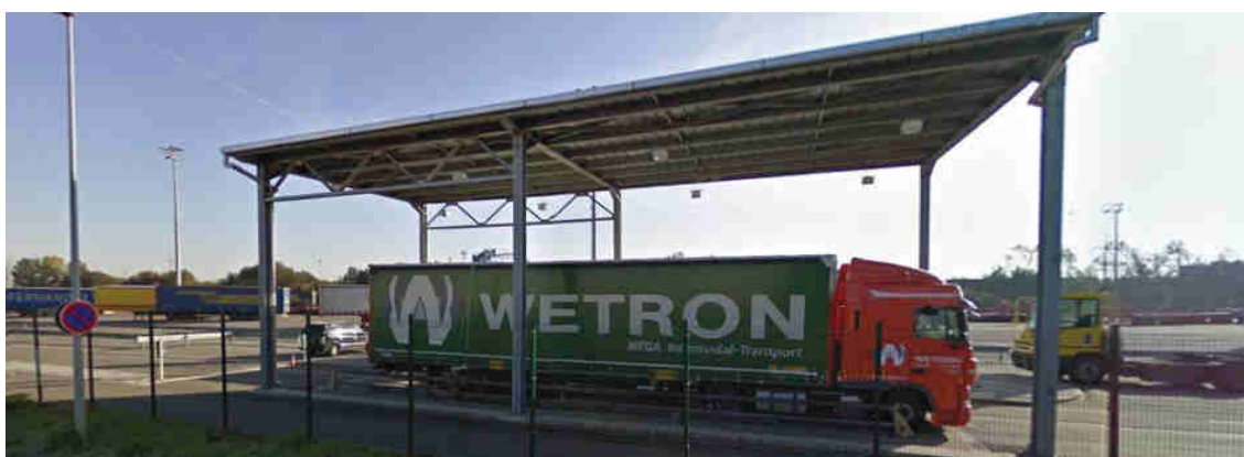
Figure 2-14. Une bascule avec contrôle de gabarit et de poids.
