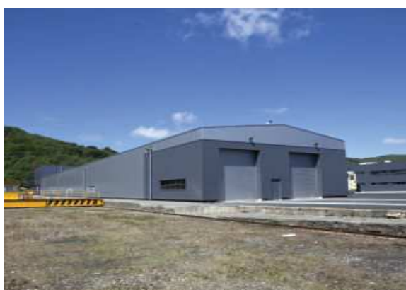
Usine de Bagnères de Bigorre (France), 23.500 m 2
