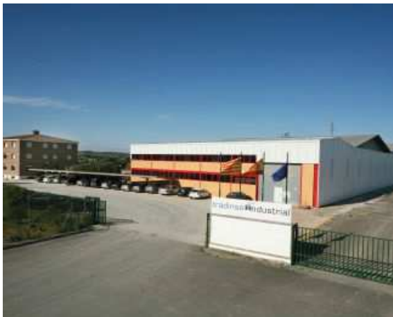
Usine de Lérida (Espagne), 18.190 m 2
