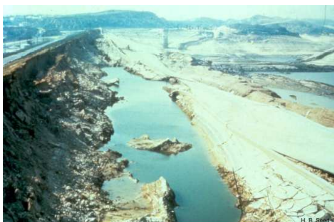
Figure 3-1 - Barrage de Lower Van Norman après le séisme de San Fernando en 1971
