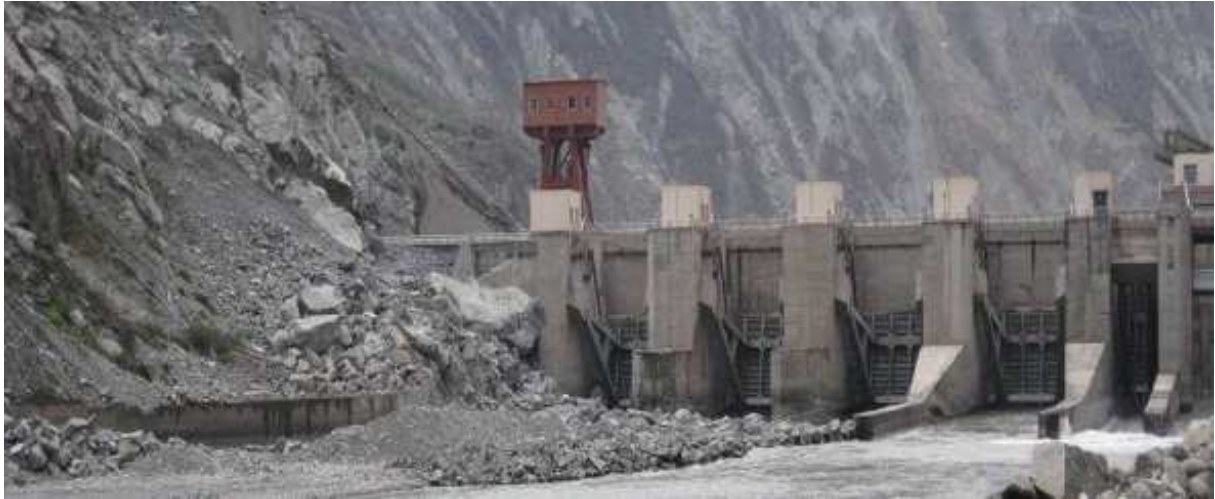
Figure 8-6 - Séisme de Wenchuan – mai 2008 : évacuateur de crue partiellement bloqué par un écroulement rocheux (photo M. Wieland).
