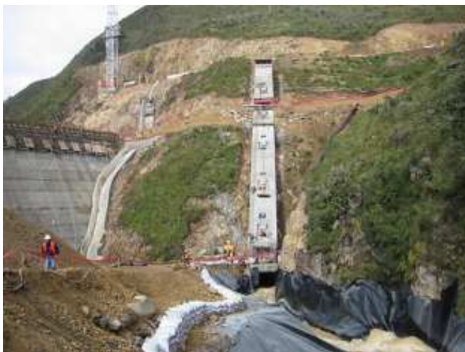
Figure 8-8 – Tour de prise d'eau inclinée – Rio Grande – Pérou
