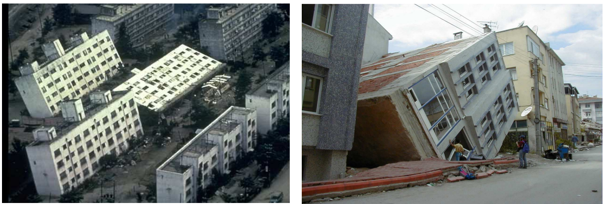
Figure 5-10 - Liquéfaction à Niigata (Japon 1964) et à Izmit (Turquie 1999)
