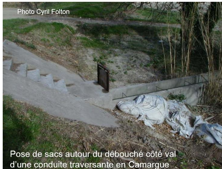
Figure 5.2 : Pose de sacs autour du débouché côté val d'une conduite traversante en Camargue
