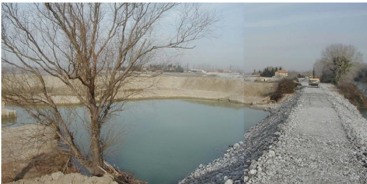
Figure 5.5 : Vue panoramique des remblais de fermeture en crue et post-crue de la brèche de Claire-Farine (Petit Rhône rive droite, décembre 2003)- Photo P. Mériaux, Irstea.
