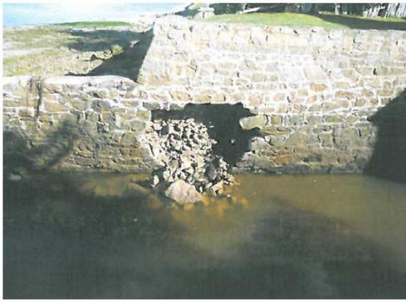
Éboulement d'une partie du parement de la digue
