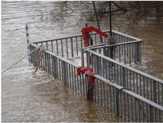
Passerelle d'accès à la manœuvre de la vanne de fond (submergée)
