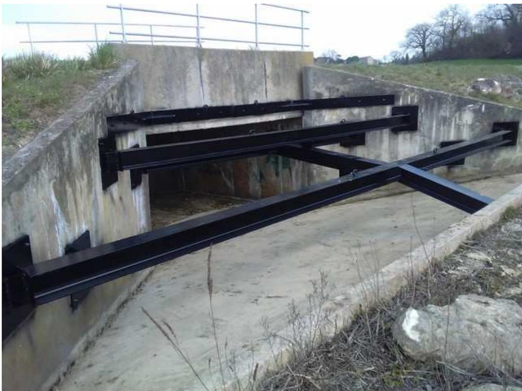
*Barrage de Bousquetera - étayage renforcé pendant les travaux réalisés en 2016*
