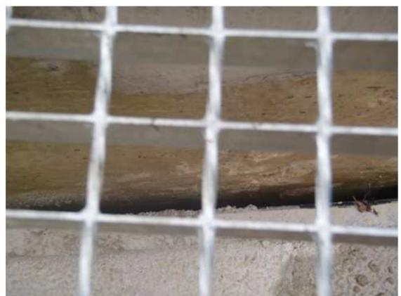
Joint ouvert entre l'évacuateur et le corps du barrage
