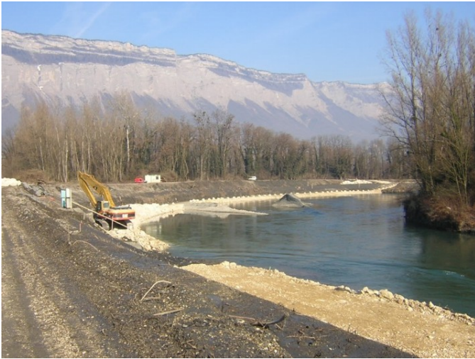
Illustration 52 : Travaux en pied de talus – ADIDR
