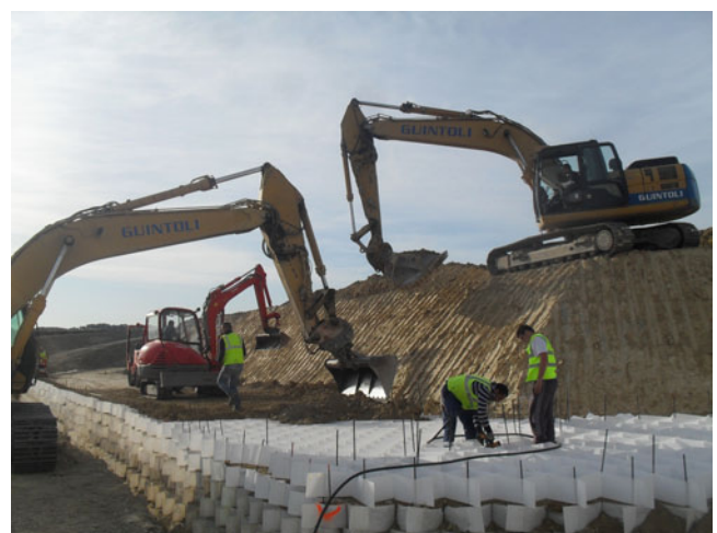
Illustration 85 : Remplissage de géogrille – Symadrem
