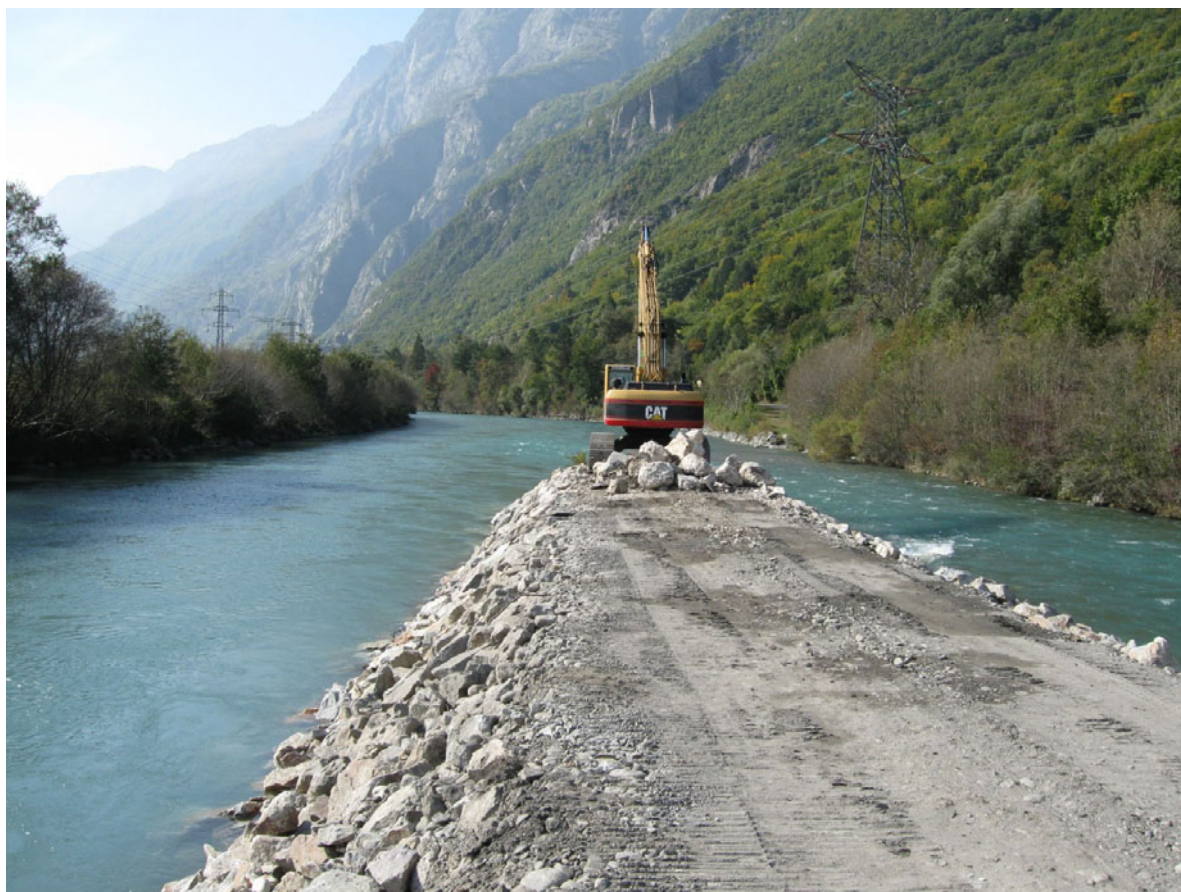
Illustration 72 : Reconstruction d'un épi de confluence en enrochement – ADIDR
