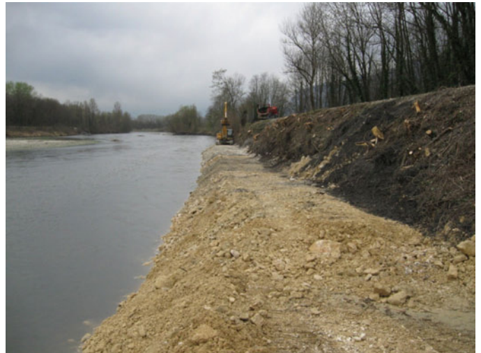
Illustration 53 : Piste d'accès brut de minage – ADIDR
