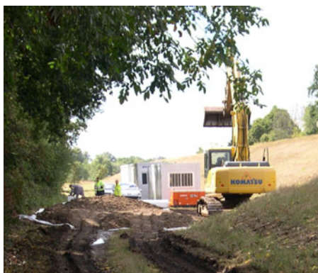
Illustration 23 : Installation de chantier – DREAL Centre
