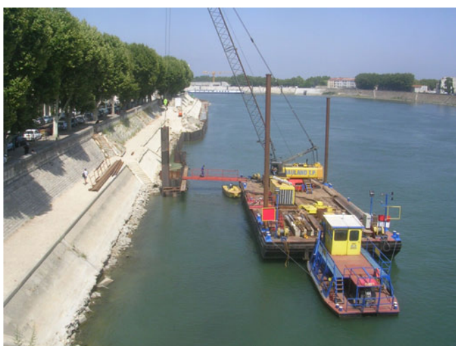
Illustration 66 : Travaux de palplanches sur perré – Symadrem
