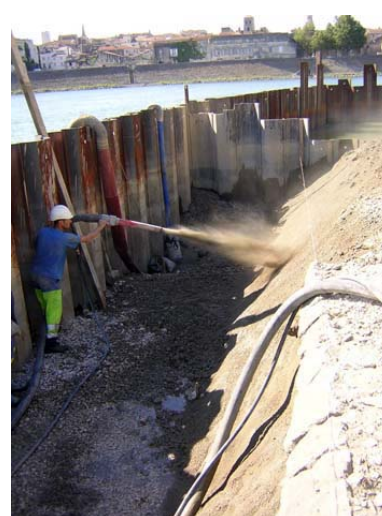
Illustration 67 : béton projeté – Symadrem
