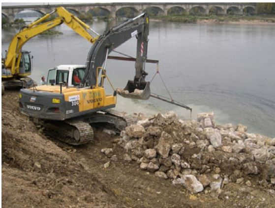
Illustration 50 : Mise en œuvre d'enrochement – DREAL Centre
