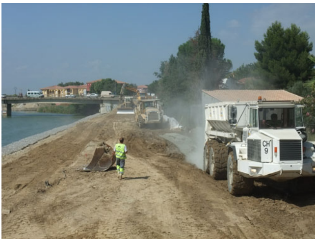
Illustration 84 : Traitement à la chaux
