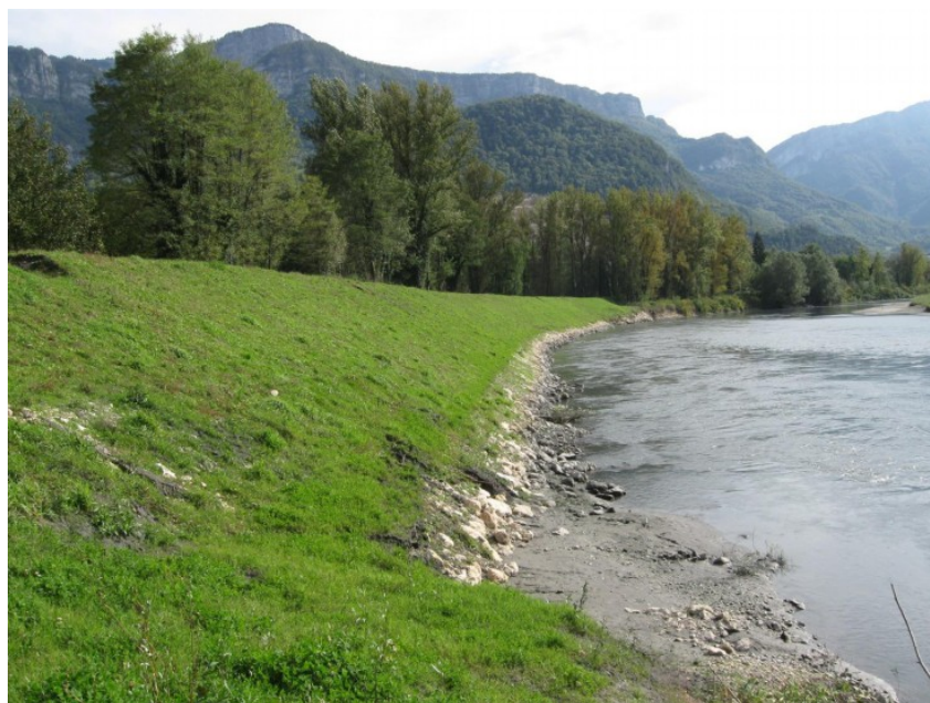
Illustration 10 : Digue végétalisée - ADIDR
