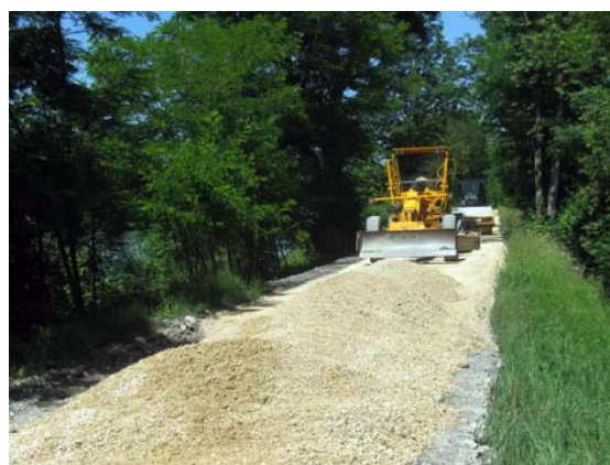
Illustration 64 : Nivellement concassé – ADIDR
