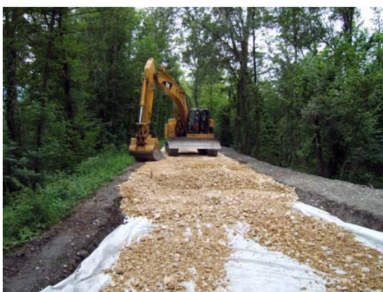
Illustration 63 : Mise en œuvre de concassé sur géotextile – ADIDR
