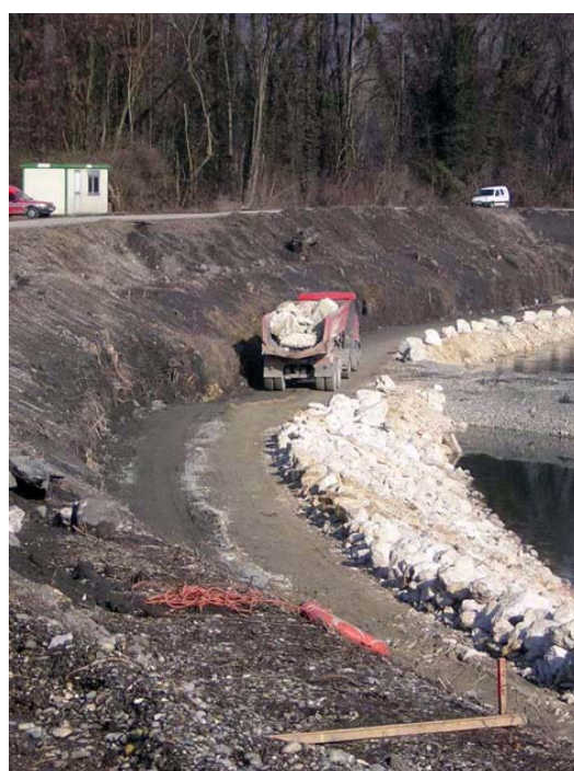
Illustration 54 : Enrochement en pied de talus – ADIDR
