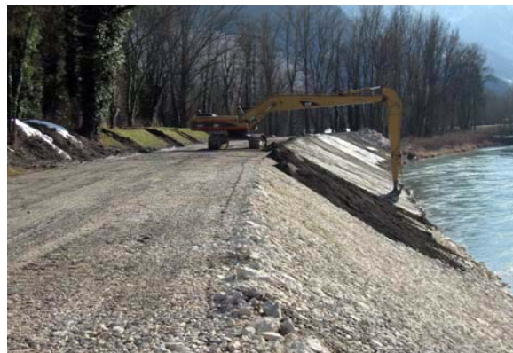
Illustration 46 : Couverture de terre végétale après réglage du talus – ADIDR
