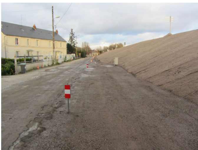
Illustration 90 : Géotextile biodégradable côté val – DREAL Centre
