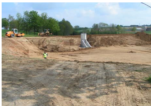
Illustration 74 : Vue sur l'ouvrage hydraulique – SMBVAS
