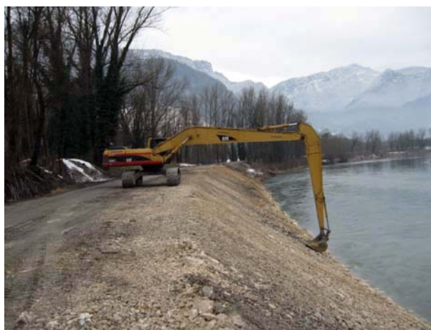
Illustration 87 : réglage à la pelle du matériau d'apport – ADIDR
