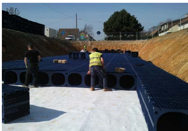
Illustration 77 : Pose de modules – CCCF
