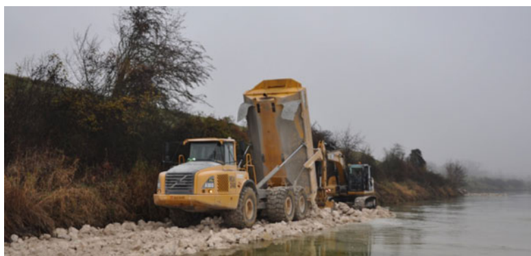
Illustration 56 : Mise en œuvre d'enrochement – DREAL Centre
