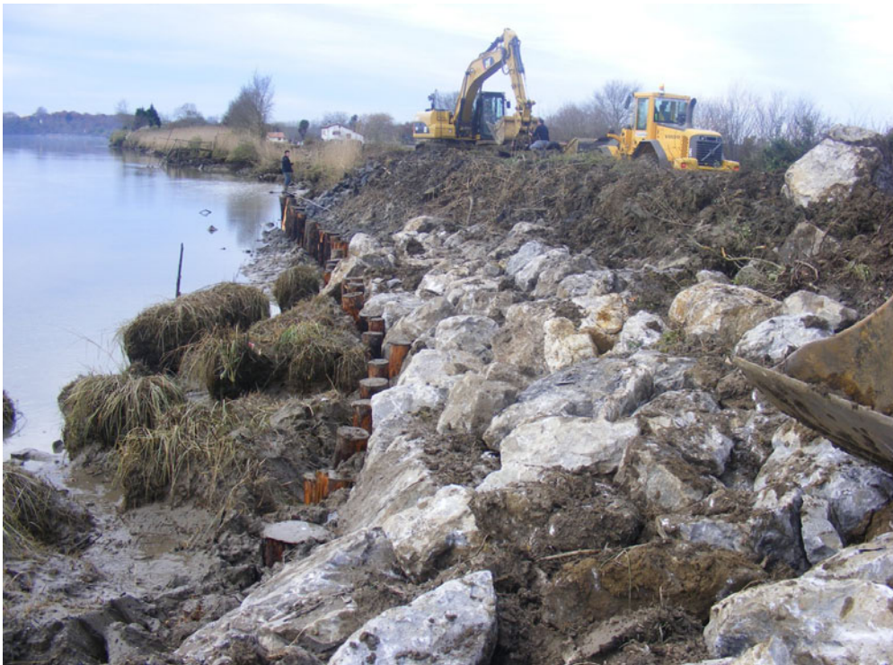
Illustration 38 : Travaux d'enrochement – Institution Adour
