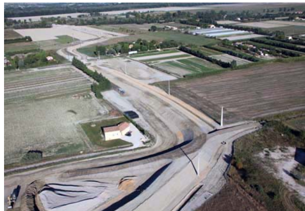
Illustration 35 : Construction de digue – Vue aérienne – Symadrem
