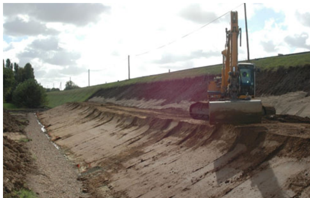
Illustration 45 : Mise en place d'un filtre drain côté val – DREAL Centre
