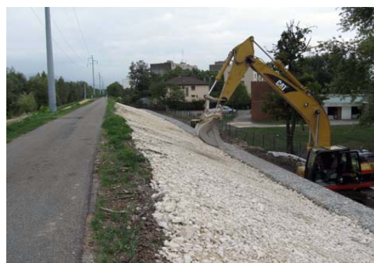
Illustration 60 : mise en œuvre de la recharge drainante – ADIDR
