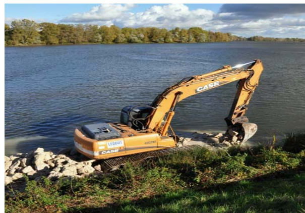
Illustration 47 : Travaux d'enrochement – DREAL Centre
