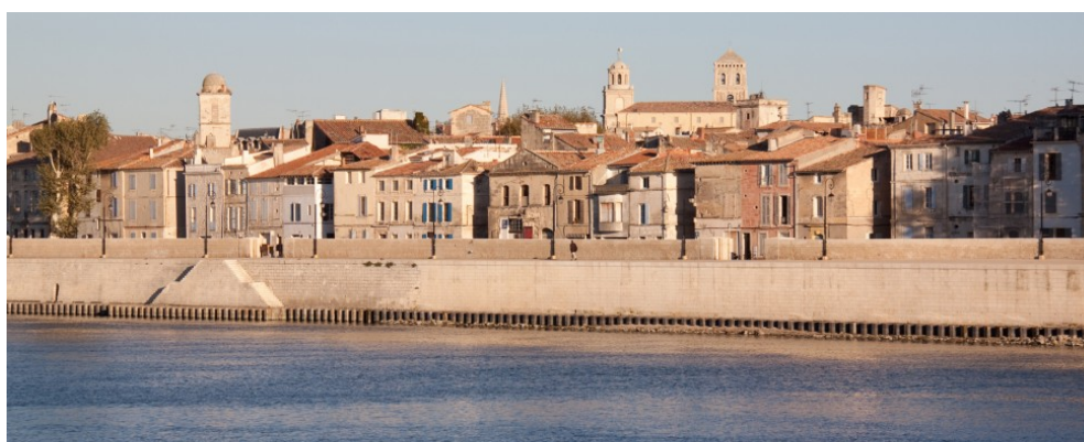
Illustration 71 : ouvrage après intervention – Symadrem
