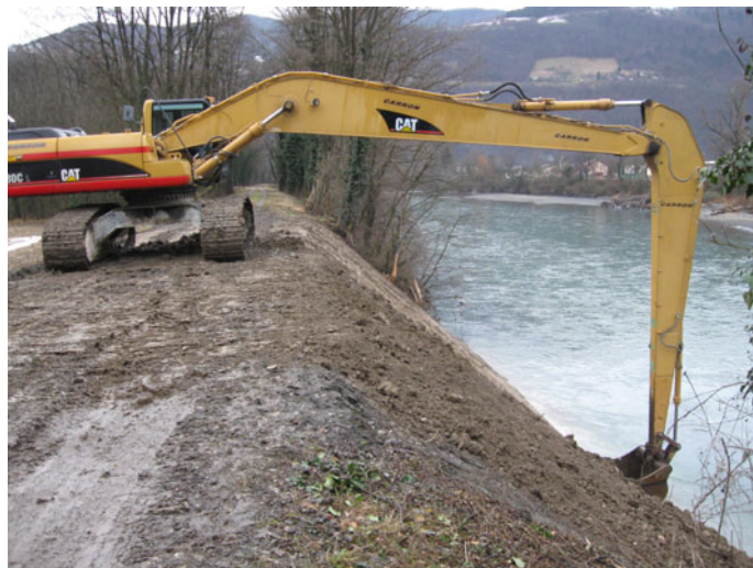
Illustration 94 : mise en œuvre de terre végétale – ADIDR
