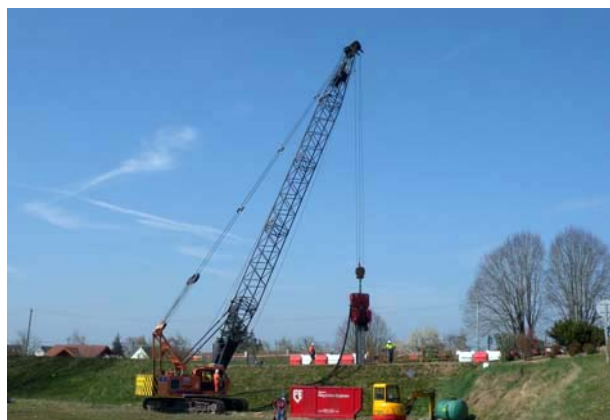
Illustration 39 : Vibrofonçage de palplanches – Vue d'ensemble – DREAL Centre
