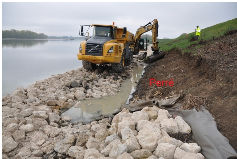
Illustration 22 : Intervention sur la partie basse d'un « perré maçonné » – DREAL Centre
