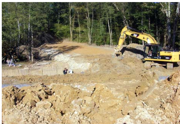
Illustration 36 : Chantier de terrassement – Institution Adour
