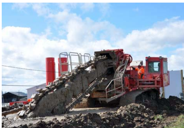
Illustration 43 : Paroi au coulis mélangé – Gros plan sur le matériel – DREAL Centre
