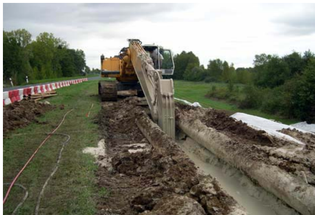
Illustration 41 : Paroi au Coulis – Creusement de la tranchée – DREAL Centre
