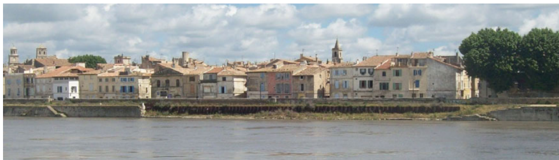
Illustration 68 : Arles – Quai de la Roquette avant intervention – Symadrem
