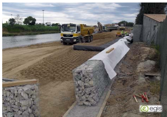
Illustration 58 : mise en place de gabions – Symadrem/Egis
