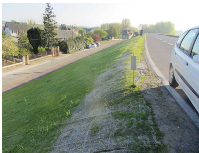
Illustration 91 : Géotextile biodégradable côté val après repousse du gazon – DREAL Centre
