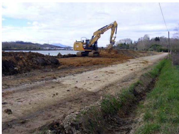
Illustration 79 : Terrassement en déblai – Institution Adour
