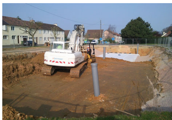
Illustration 78 : Remblaiement – CCCF
