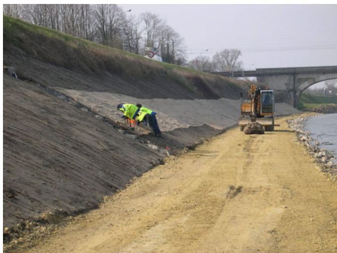
Illustration 92 : Pose de géotextile biodégradable côté Loire – DREAL Centre
