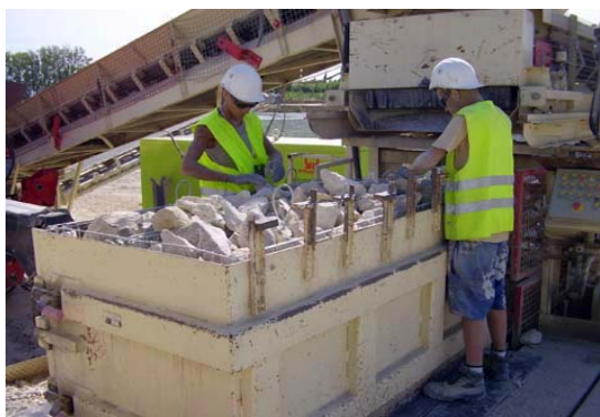
Illustration 57 : Confection d'un gabion – Symadrem
