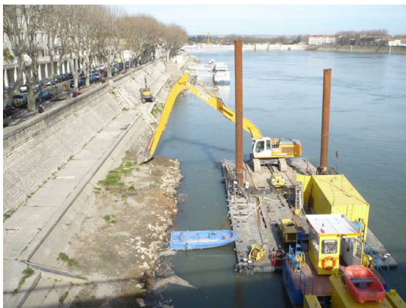
Illustration 65 : Déblaiement préalable à la réfection du perré – Symadrem
