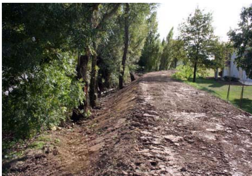
Illustration 81 : Terrassement en remblai – SIJALAG
