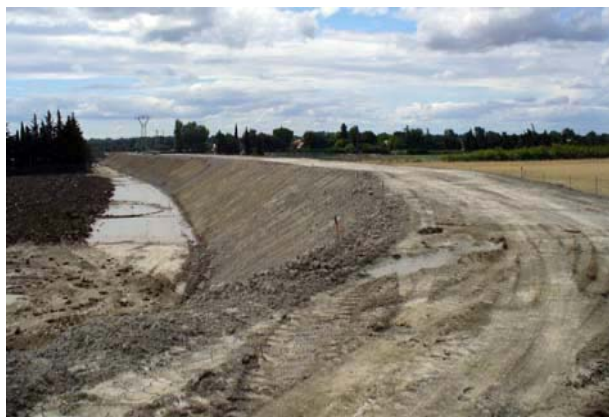
Illustration 34 : Travaux de construction de digue – Terrassement – Symadrem
