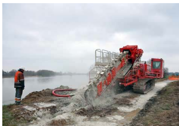
Illustration 44 : Paroi au coulis mélangé – matériel en action – DREAL Centre
