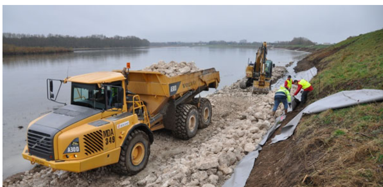
Illustration 55 : Mise en œuvre d'enrochement – DREAL Centre
