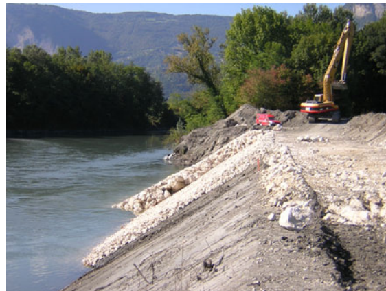
Illustration 51 : Carapace et sous-couche d'enrochement – ADIDR
