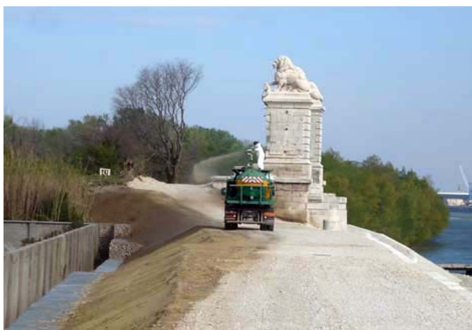
Illustration 95 : Ensemencement par voie hydraulique – Symadrem
