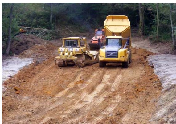
Illustration 86 : Apport de matériau d'une zone d'emprunt – Institution Adour
