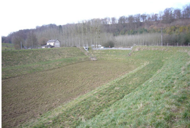
Illustration 20 : Bassin de rétention à vide – SMBVAS
