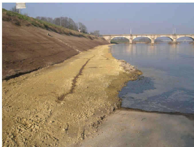
Illustration 93 : Pose de géotextile biodégradable côté Loire – DREAL Centre
