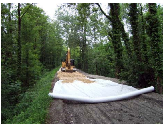
Illustration 88 : Mise en œuvre de concassé sur géotextile anti-contaminant – ADIDR
