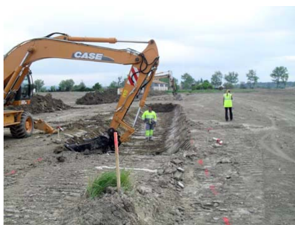
Illustration 80 : Digue Nord d'Arles, clef d'ancrage – Symadrem
