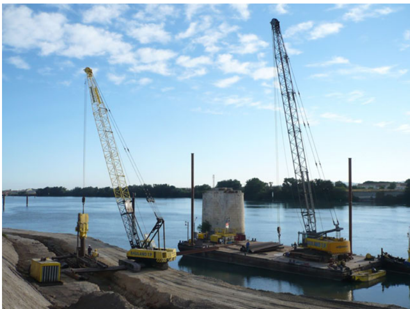
Illustration 62 : travaux de vibro-fonçage de palplanches – Symadrem
