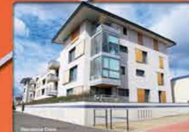
Une opération de logements collectifs réalisée par Paul Chematov. Les parkings en rez-de-chaussée rehaussent le bâtiment. Le soubassement est marqué d'une ligne en carrelage bleu installée à hauteur d'eau.
