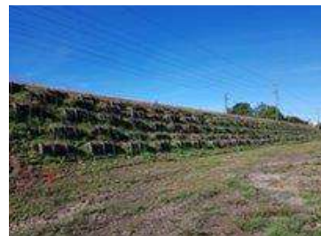
Instrumentation et végétalisation du remblai de Nioux près de Saincaize
