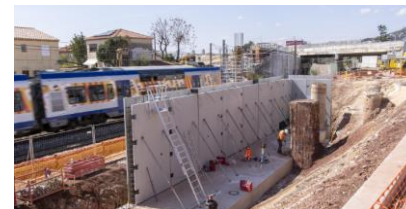
Exemple de travaux à proximité des voies
