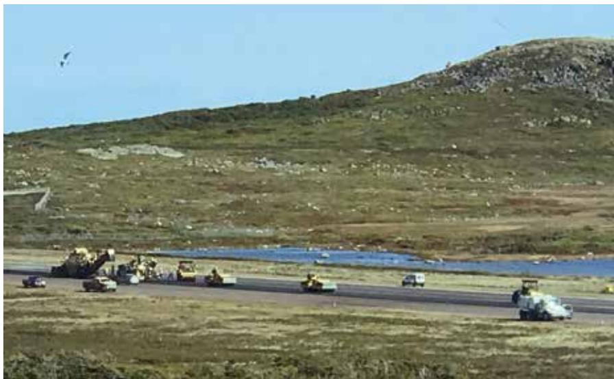
*Saint-Pierre-et-Miquelon : travaux de resurfacement de la piste de 1 800 mètres avec 400 feux de balisage à changer. Pour maintenir l'exploitation du terrain, des procédures d'approche satellitaires provisoires avec guidage vertical (LPV) permettant un atterrissage en seuil décalé ont été mises en œuvre grâce au système nord-américain WAAS (accord de coopération DSNA-FAA) / Été 2017.*
