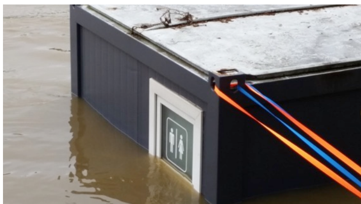
Toilettes de berges Ma Terrazza © Robin des Bois
