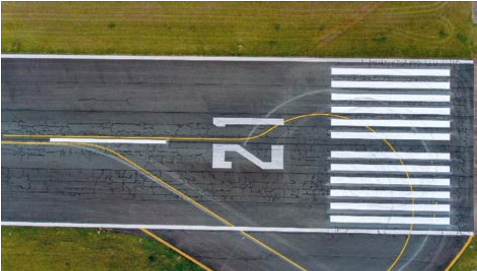
Figure C 41 : Vue aérienne d'un seuil de piste.
