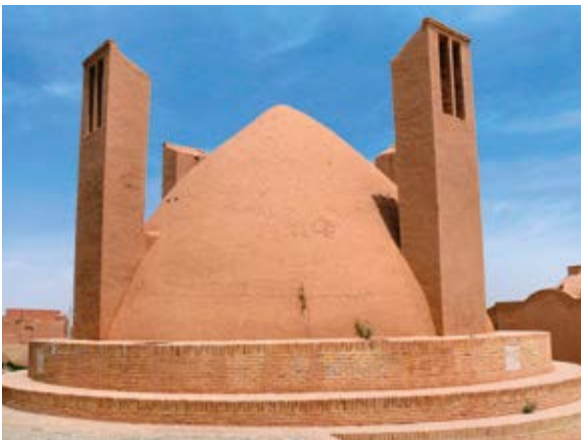
Figure F 7 : Un bâdgir : système de refroidissement naturel typique du désert iranien.
