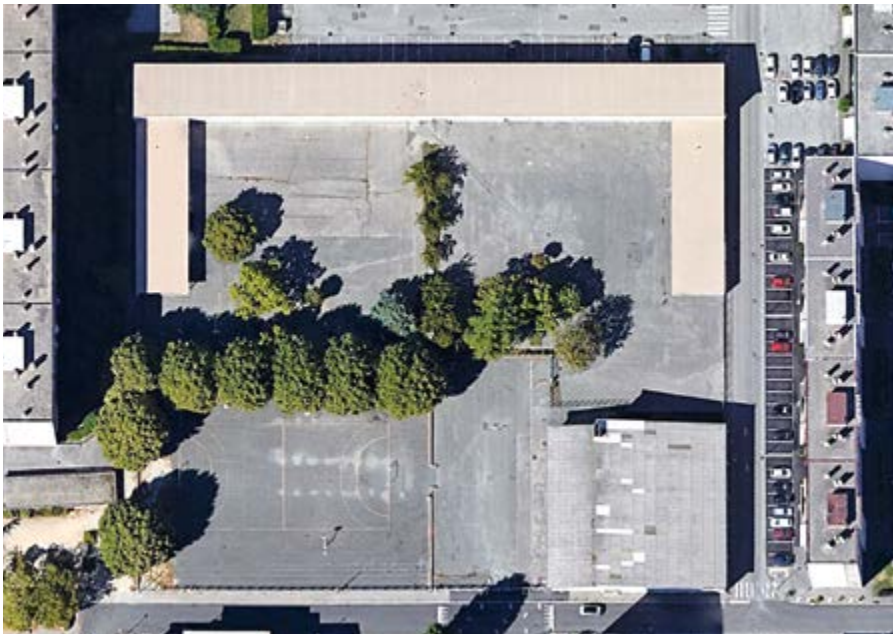
Figure F 9 : L'îlot Marcel-David avant les travaux en 2020.
