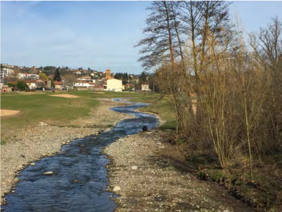
Figure F7 – La zone du Bigout après travaux.
