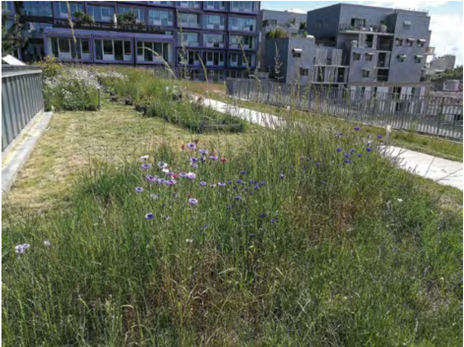
Figure E10 – La toiture végétalisée de l'école des sciences et de la biodiversité à Boulogne-Billancourt.
