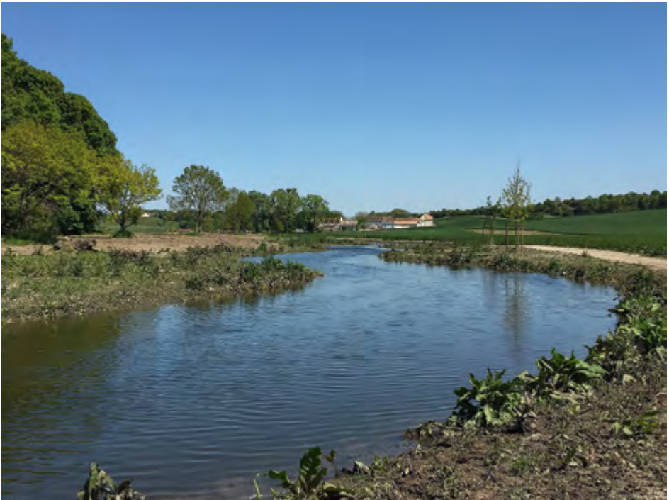
Figure D11 – Travaux de restauration écologique menés sur le Ru de Gally dans les Yvelines par Equo Vivo.
