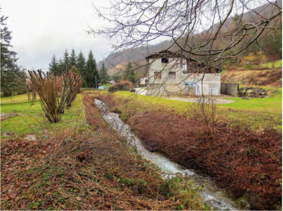
Figure F2 – Cours d'eau dégradé (rectiligne) menaçant une habitation en cas de crue.
