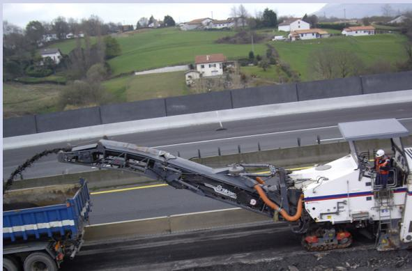
Travaux de rabotage de chaussée sur l'opération d'élargissement de l'A63 – Mars 2016
