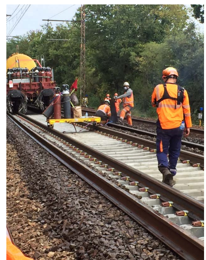
Près de 30 km de voies renouvelées par un train usine mobilisant jusqu'à 500 personnes !
