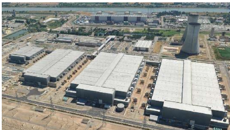
Photo n°1 : Vue d'ensemble des installations de l'usine Georges Besse 1
