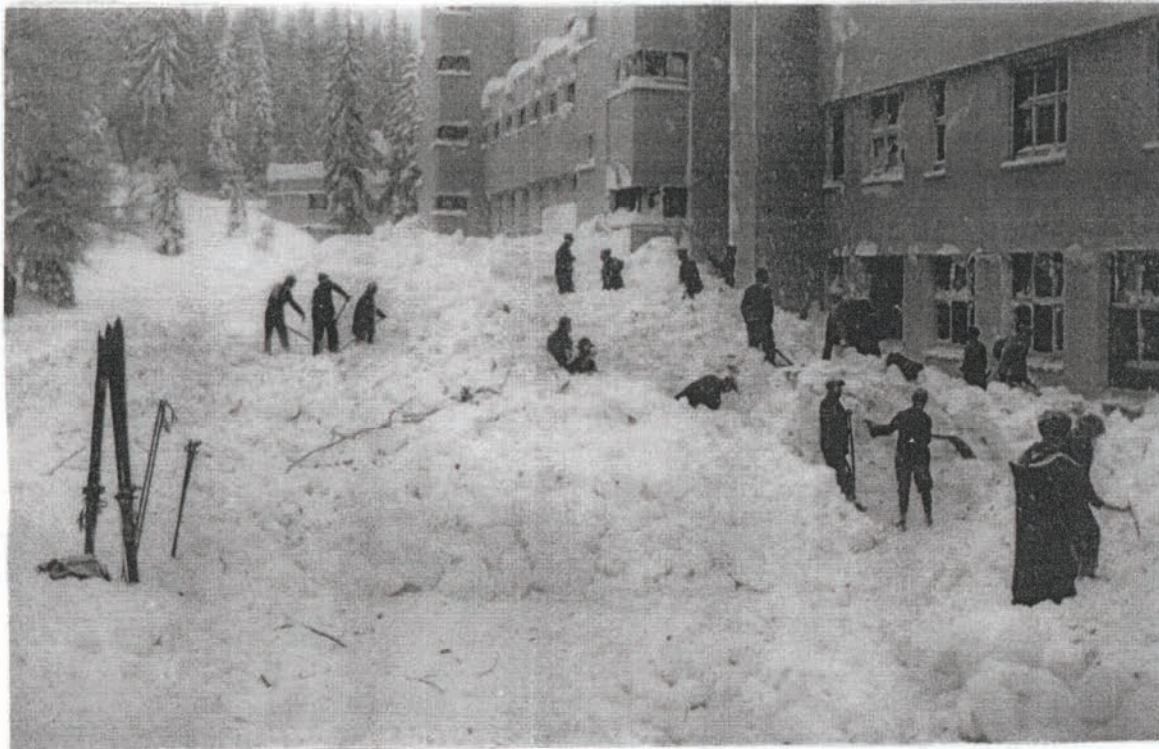
PERIMETRE DE L'ARVE - COMMUNE DE PASSY - Le Sanatorium de Guébriant immédiatement après l'avalanche de neige du 31 Janvier 1942 Cl. GIGUET (gestionnaire du Sana) du 2 Février 1942
