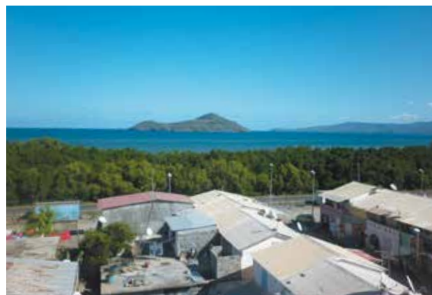
Des solutions de rénovation adaptées au climat de mahorais existent, n'hésitez pas à vous renseigner.
