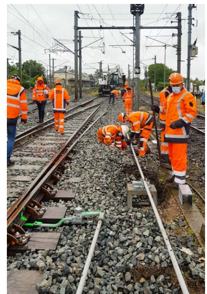
Les travaux maintenus lors du premier confinement malgré la pandémie
